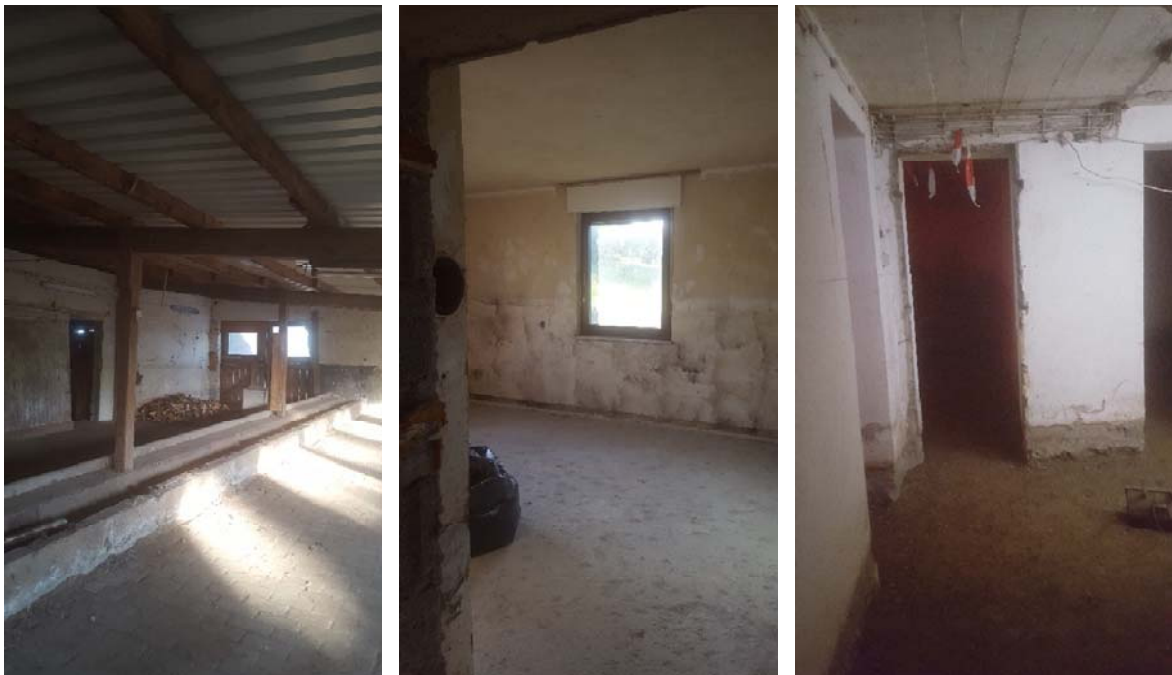
Abb. 20: Beispiele für den Innenbereich der Stallungen ( links ), Innenräume ( Mitte ) und Kellerbereiche ( rechts ) des Wohngebäudes des östlichen Aussiedlerhofs im Plangebiet.
