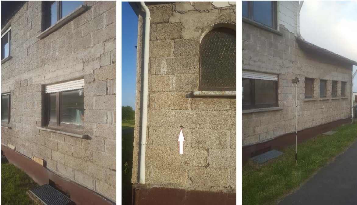
Abb. 22: Beispiele von potentiell für die Zwergfledermaus geeigneten Spaltenquartieren ( links: Rollladenkästen, Mitte: Spaltenraum im Mauerwerk, mit Pfeil markiert) an dem Wohngebäude des östlichen Aussiedlerhofs. Rechts: In unmittelbarer Nähe zu den potentiell geeigneten Spaltenquartieren aufgestelltes akustisches Aufnahmesysteme zur Kontrolle ausfliegender Tiere.
