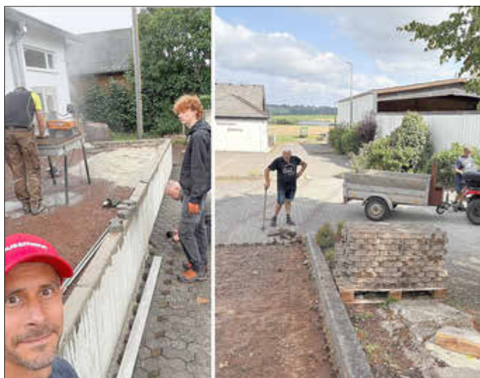
Anbau Feuerwehrhaus und Zufahrt Backes nimmt Formen an.
