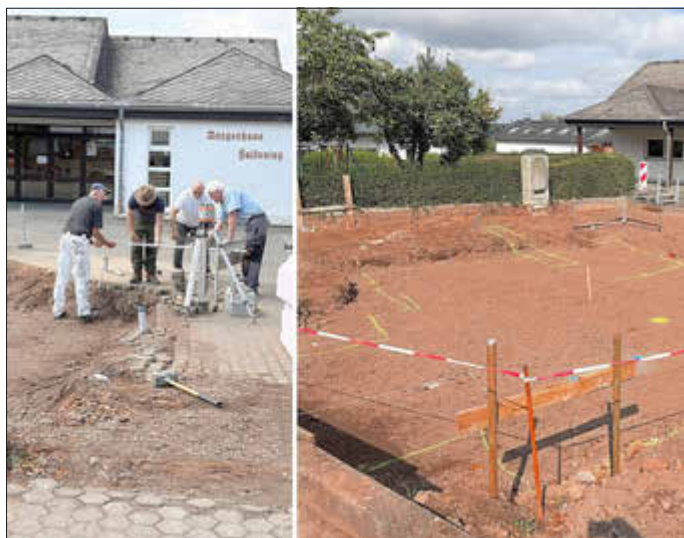
Schnurgerüst für Bodenplatte Backes ist fertig.
