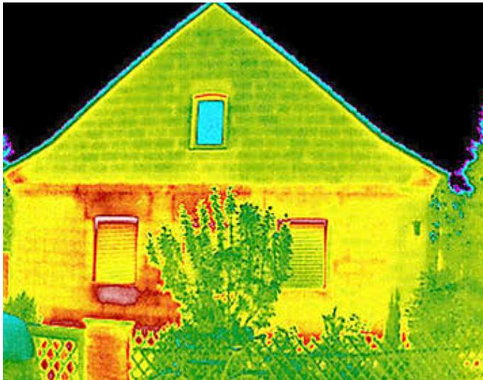
Im Wärmebild lässt sich erkennen, dass über Rollladenkästen und Fensterbänke der linken Haushälfte viel Wärme nach draußen gelangt (im Bild rot gefärbt)
