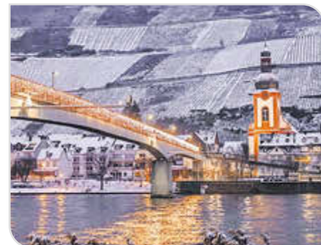
Fußgängerbrücke Zell-Kaimt mit Blick Richtung Kath. Kirche St. Peter, Zell
